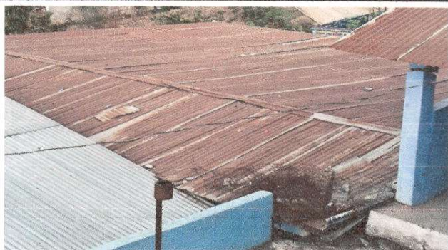
Foto 1: Sustitucion de lamina, por lámina torquelada Aluzinc calibre 26
