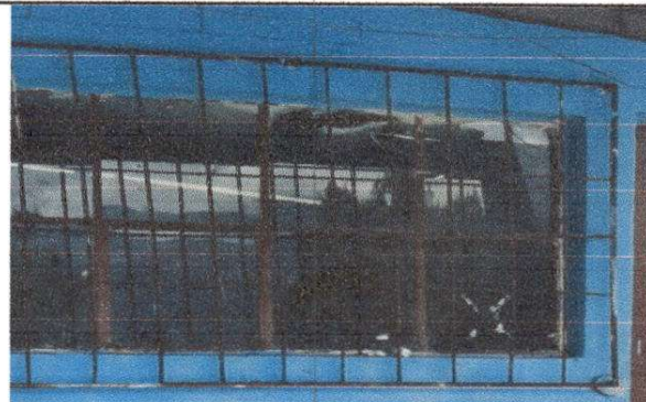
Foto 4: Sustitución de balcones de metal
