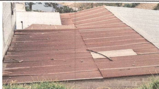
Foto 2: Sustitucion de lamina, por lámina torquelada Aluzinc calibre 26
