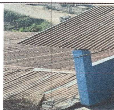
Foto 10: Reparación de bajada de agua pluvial, tubo PVC 4"
